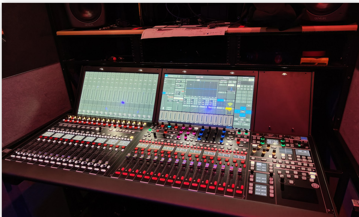
Новая консоль Lawo в процессе тестирования и инсталляции в ПТС 4К ONE
