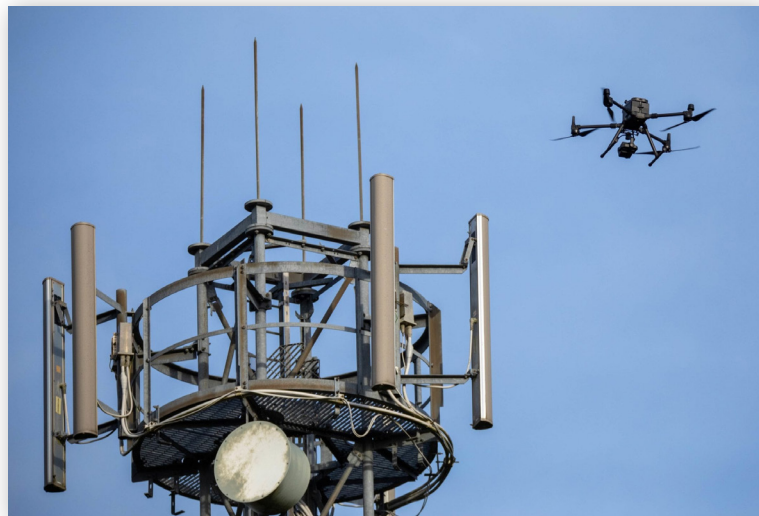
Осмотр передающей башни с помощью дрона
