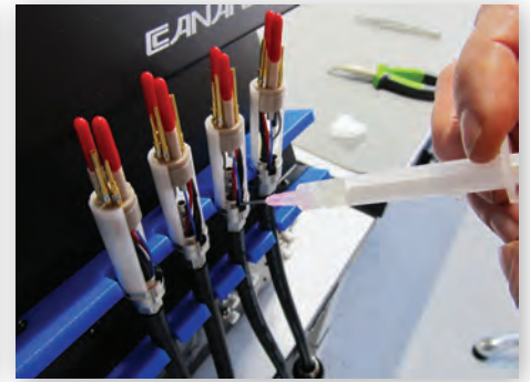
Компаундирование разъемов Canare
