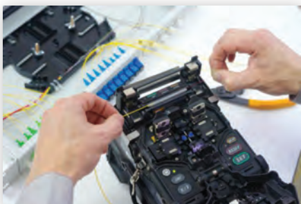
Рис. 5. Сварка магистрального и оконечного волокон
