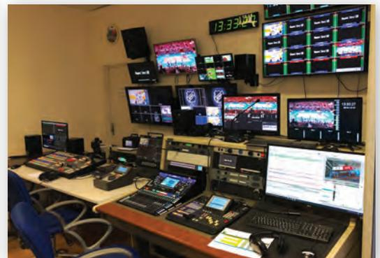
Вещательные аппаратные, где установлены системы автоматизации SkyLark SL NEO (слева направо, сверху вниз): «Рен ТВ» – на 12 каналов; «Ред Медиа» – 64 канала; «Старт»
